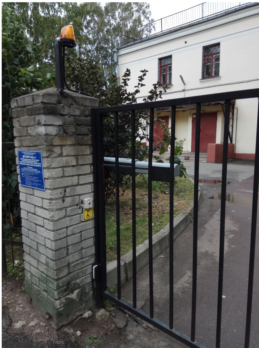
Здание ГБДОУ д.с. №1 по адресу пр. Маршала Говорова, 24, корп.2
